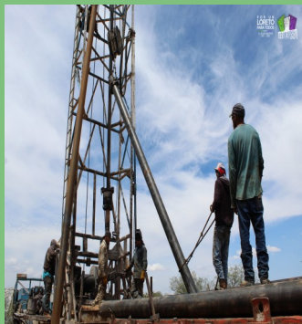
COLOCACIÓN DE TUBERÍA PARA LA CONSTRUCCIÓN DEL POZO DE AGUA POTABLE EN LA COMUNIDA DE BIMBALETES
